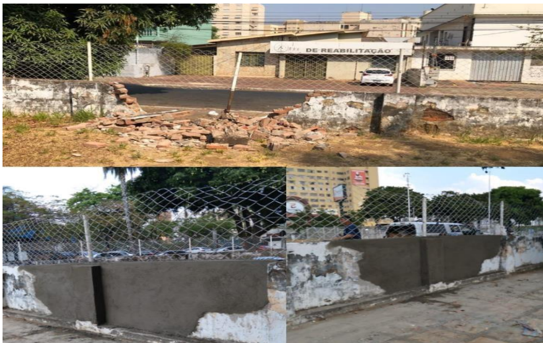
Figura 5.22: Recuperação do muro da Estação Meteorológica de Goiânia/GO
