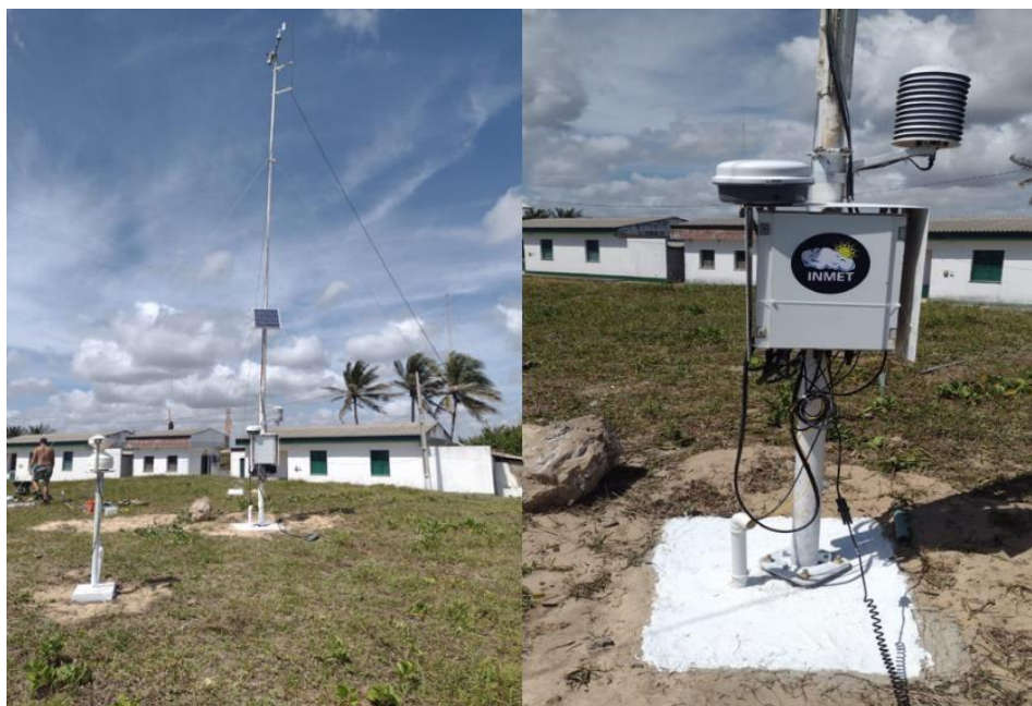
Figura 5.41: Estação A344 RN restivada após a manutenção
